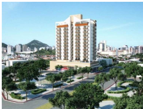
Figura 1. Perspectiva do empreendimento e seu entorno. Fonte: Construtora, 2015.
